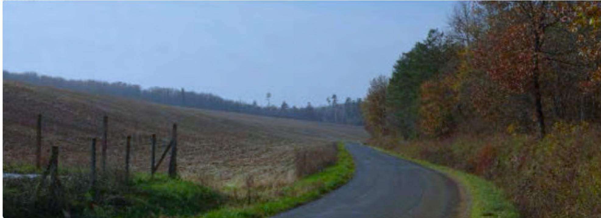
Vue A - état initial
